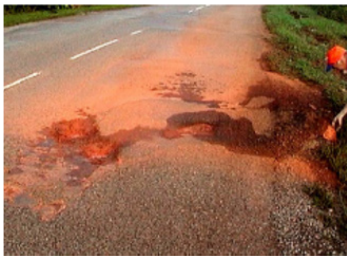
Figure 5 Dégradation en rive (19 ans de service en Guyane)
