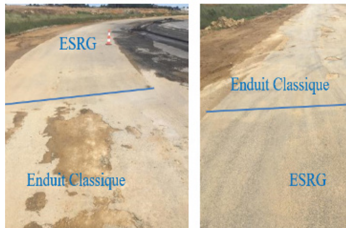
Figure 6 - Expérimentation sur le chantier Ariane 6 - Trafic chantier
