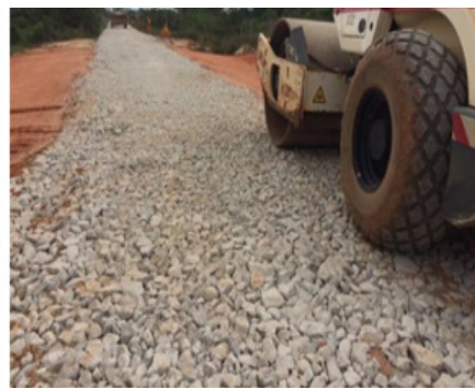
Couche de forme en Grave – Pistes agricoles de Wayabo / commune de
