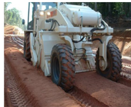
Traitement de la couche de forme - Route d' Apatou
