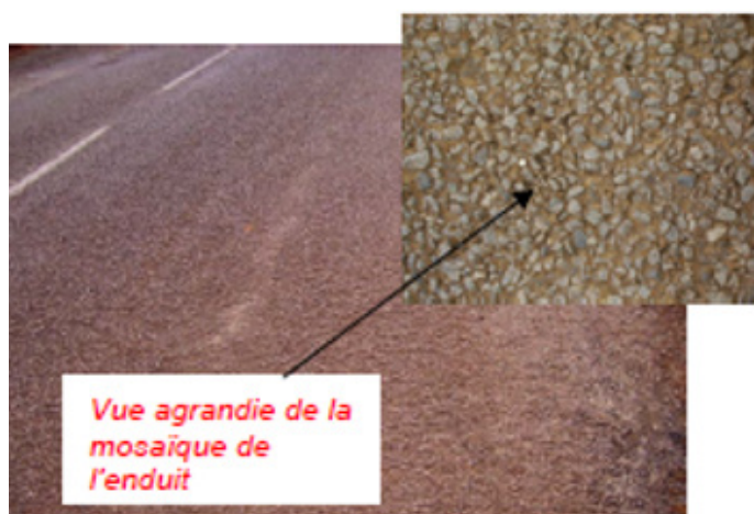
Figure 4 - Bon état général de l'enduit en Guyane
