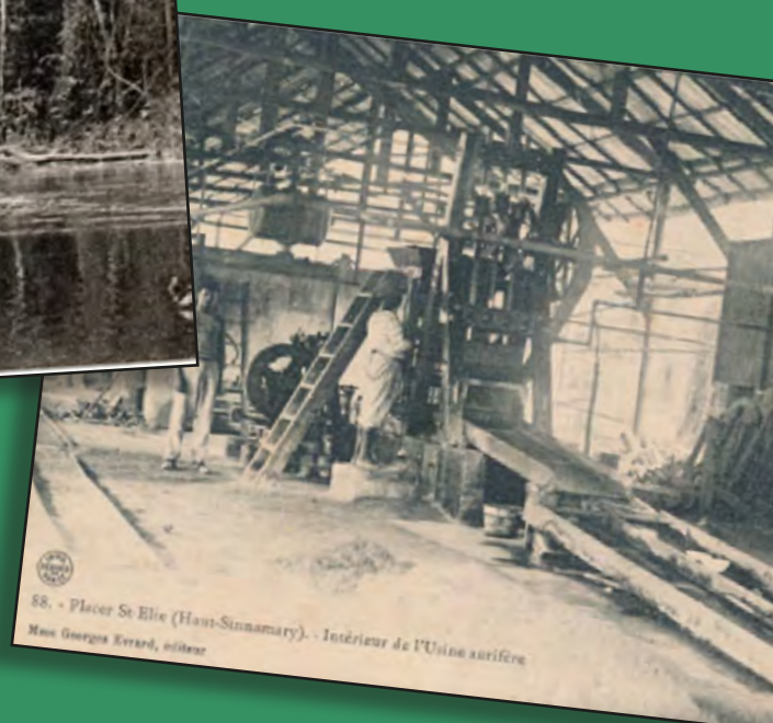
D Usine de broyage du quartz aurifère installée en 1898 à Adieu-Vat près de Saint-Élie avec depuis l'arrière-plan : machine à vapeur, broyeur à pilons et table d'amalgamation
