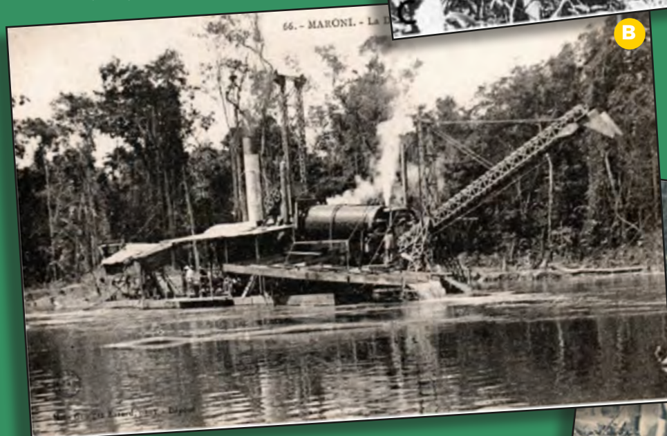
B La drague à godets Danica, de la Compagnie des Placers Guyanais ; cette société belge a exploité la crique Janvier, affluent du Maroni, et la crique Sparouine en 1903.
