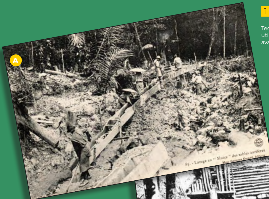
A Mineurs créoles travaillant au sluice sur un gisement alluvionnaire
